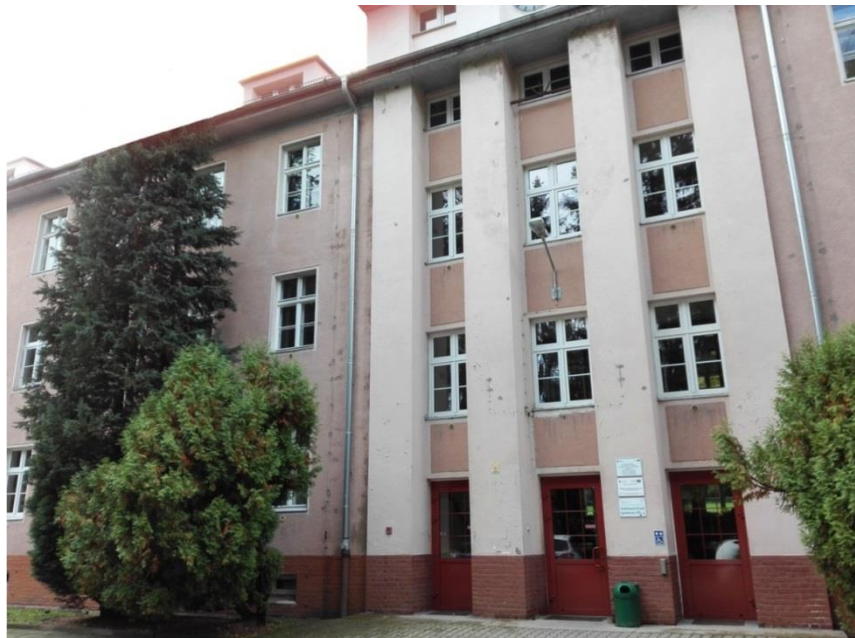
7. Budynek nr 3. Siedziba obecnego Wydziału Przyrodniczo-Technicznego.
