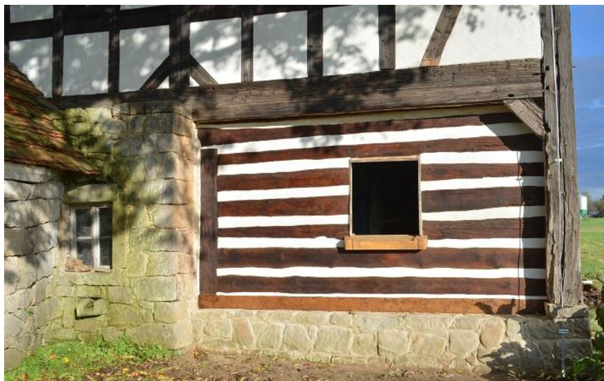
Fot. 10. Rekonstrukcja ściany izby zrębowej w domu przysłupowym – już po remoncie. Przykład udanej odbudowy. Przemurowano kamienną podmurówkę, wstawiono nowe belki (tzw. płazy), a szpary wypełniono tradycyjną metodą tj. pakułami lnianymi, które zafugowano masą z gliny i pomalowano farbą wapienną. Belki pomalowano olejem lnianym z dziegciem.
