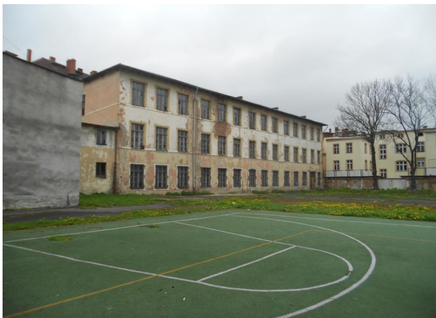
5. Budynek B Szkoły Podstawowej nr 7 w Jeleniej Górze, ul. 1 Maja /stan obecny/.
