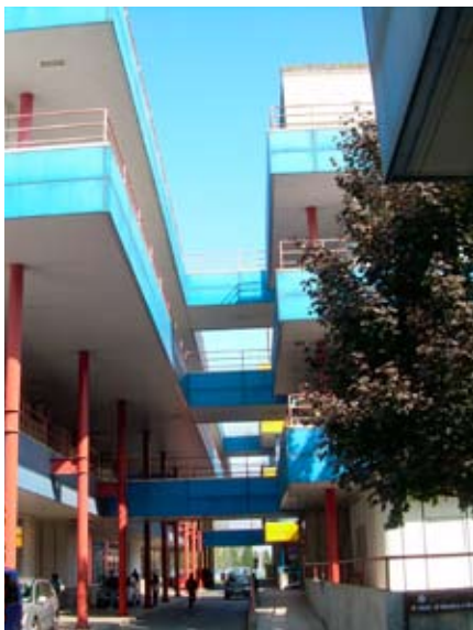
Zespół budynków Wydziału Inżynierii
