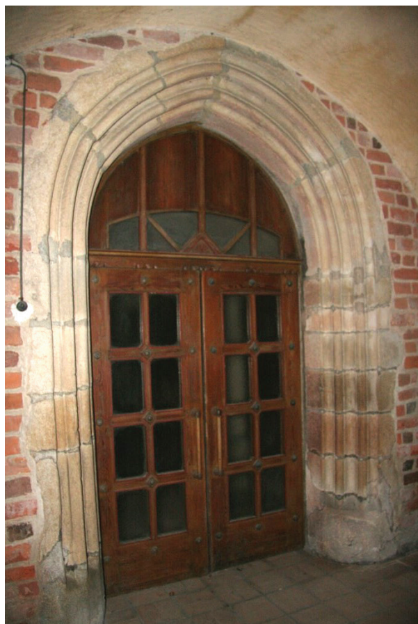
Il. 7. Lewin Brzeski, kościół pw. św. św. Piotra i Pawła, portal zachodni (fot. A. Legendziewicz)
