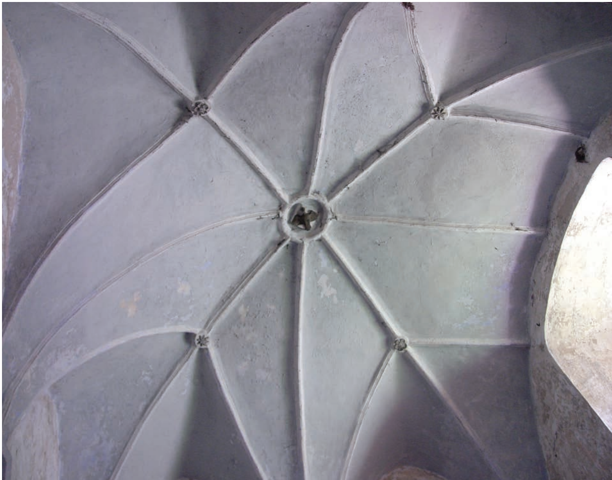
Il. 9. Lewin Brzeski, kościół pw. św. św. Piotra i Pawła, sklepienie w przyziemiu wieży z renesansową dekoracją sieciową (fot. A. Legendziewicz)
