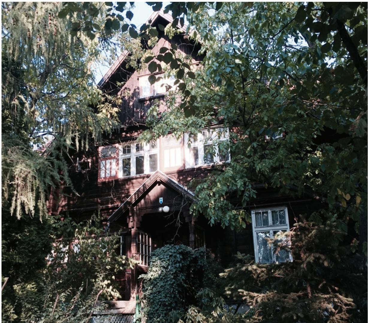
Il. 10. Willa przy ul. Chopina – elewacja frontowa z gankiem w konstrukcji drewnianej, w którym znajduje się wejście główne do obiektu (fot. J. Olesińska)
