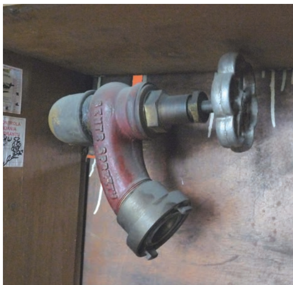
Il. 9. Hydrant wnąkowy w budynku Miejskiej Kasy Pożyczkowej (fot. P. Kirschke, 2013)
