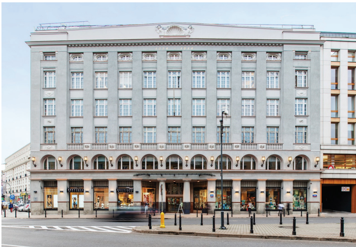
Il. 6. Fasada Domu Towarowego Bracia Jabłkowscy przy ul. Brackiej 25 w Warszawie. Stan po renowacji w listopadzie 2017 r. (fot. K. Bartczak; ilustracja ze zbiorów DTBJ S.A., Warszawa, ul. Chmielna 21)
