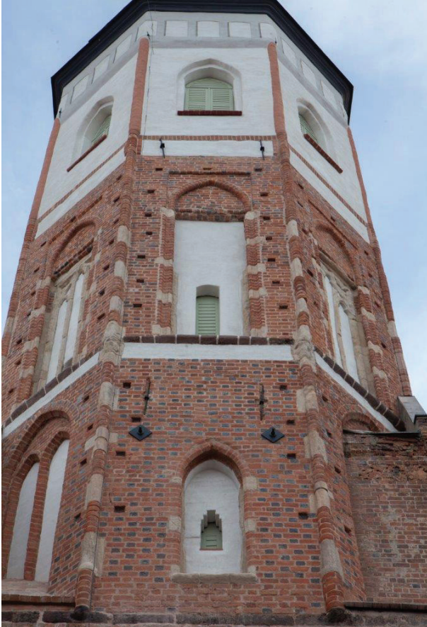
Il. 8. Koźuchów, wieża kościoła pw. MB Gromnicznej, widok elewacji północnej po zakończeniu prac (fot. A. Legendziewicz)
