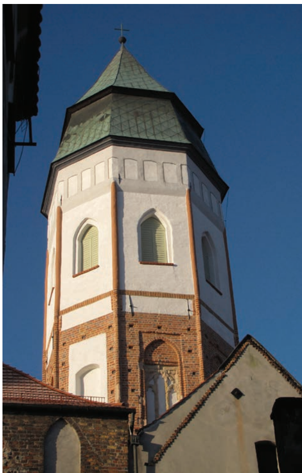
Il. 6. Koźuchów, wieża kościoła pw. MB Gromnicznej, widok od wschodu po zakończeniu prac (fot. A. Legendziewicz)
