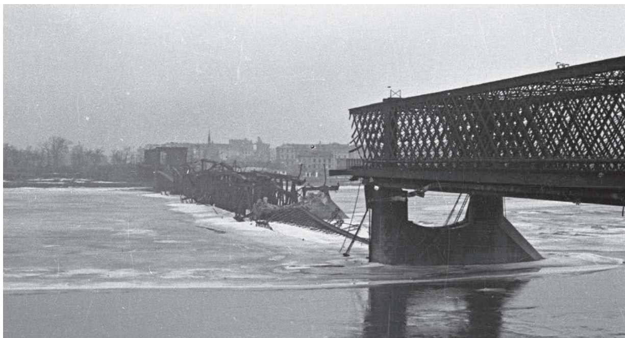
Il. 6. Zniszczony most Kierbedzia
