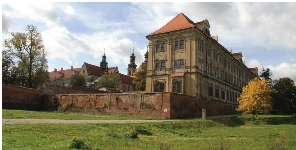
II. 6. Lubiąż, widok na pałac opata i kościół od północnego wschodu (fot. M. Dąbkowska)
