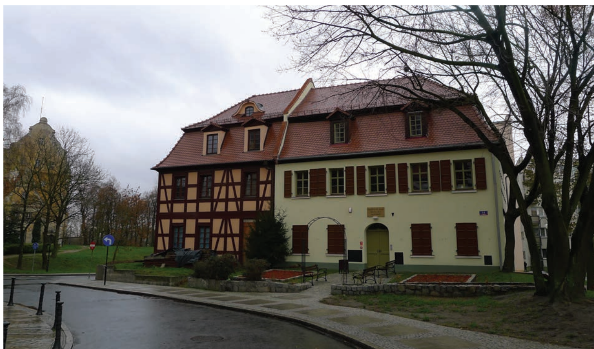
Il. 6. Budynki nr 11 i 12 przy ul. Bocianie w Oleśnicy po pracach remontowych, widok od frontu (fot. M. Małachowicz)
