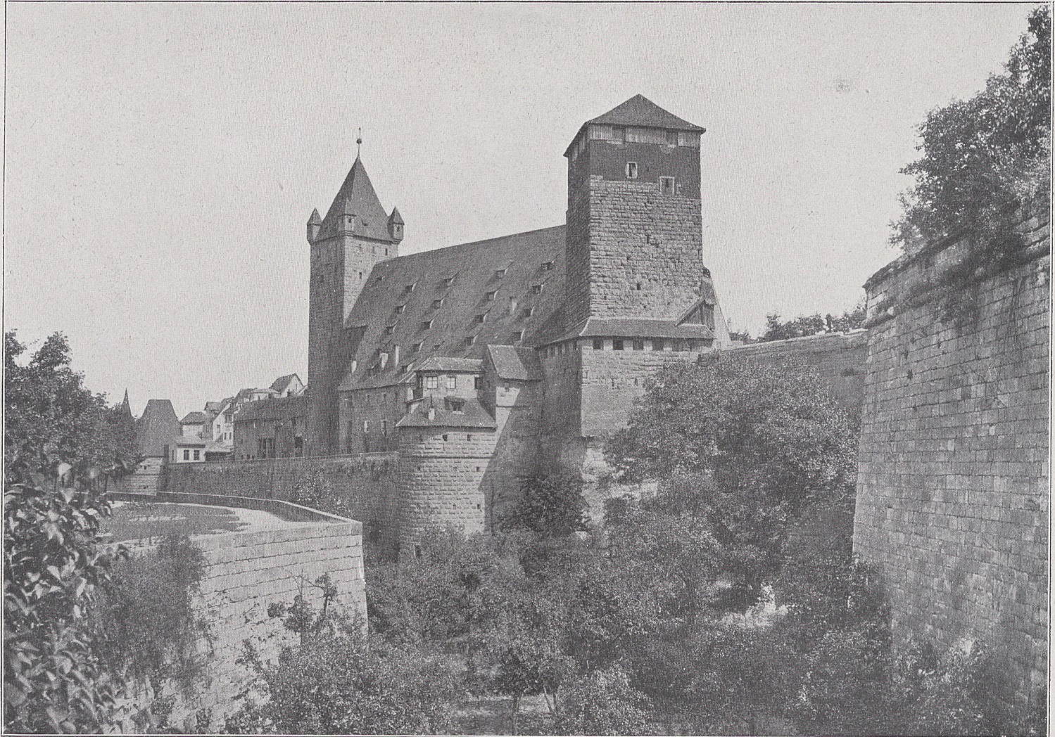
Nürnberg. Fünfeckiger Turm und Luginsland mit Torhaus.
