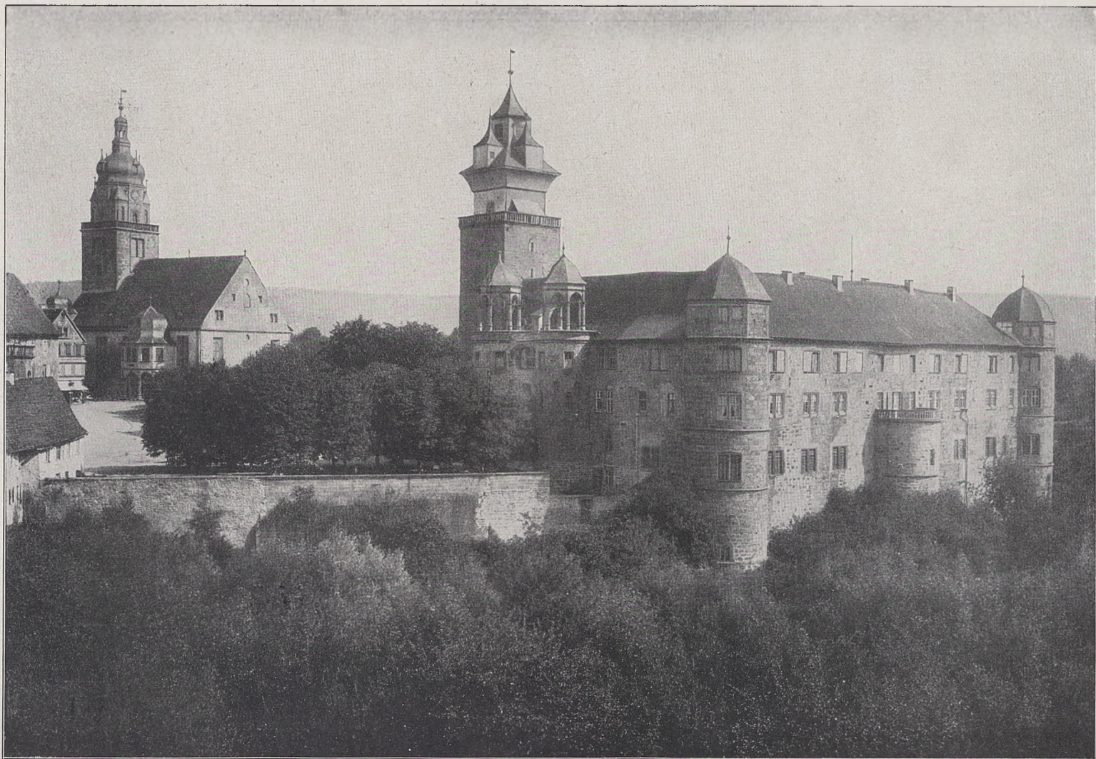
Schloß Neuenstein-Hohenlohe bei Dehringen, vor der Erneuerung. 16. Jahrh.
