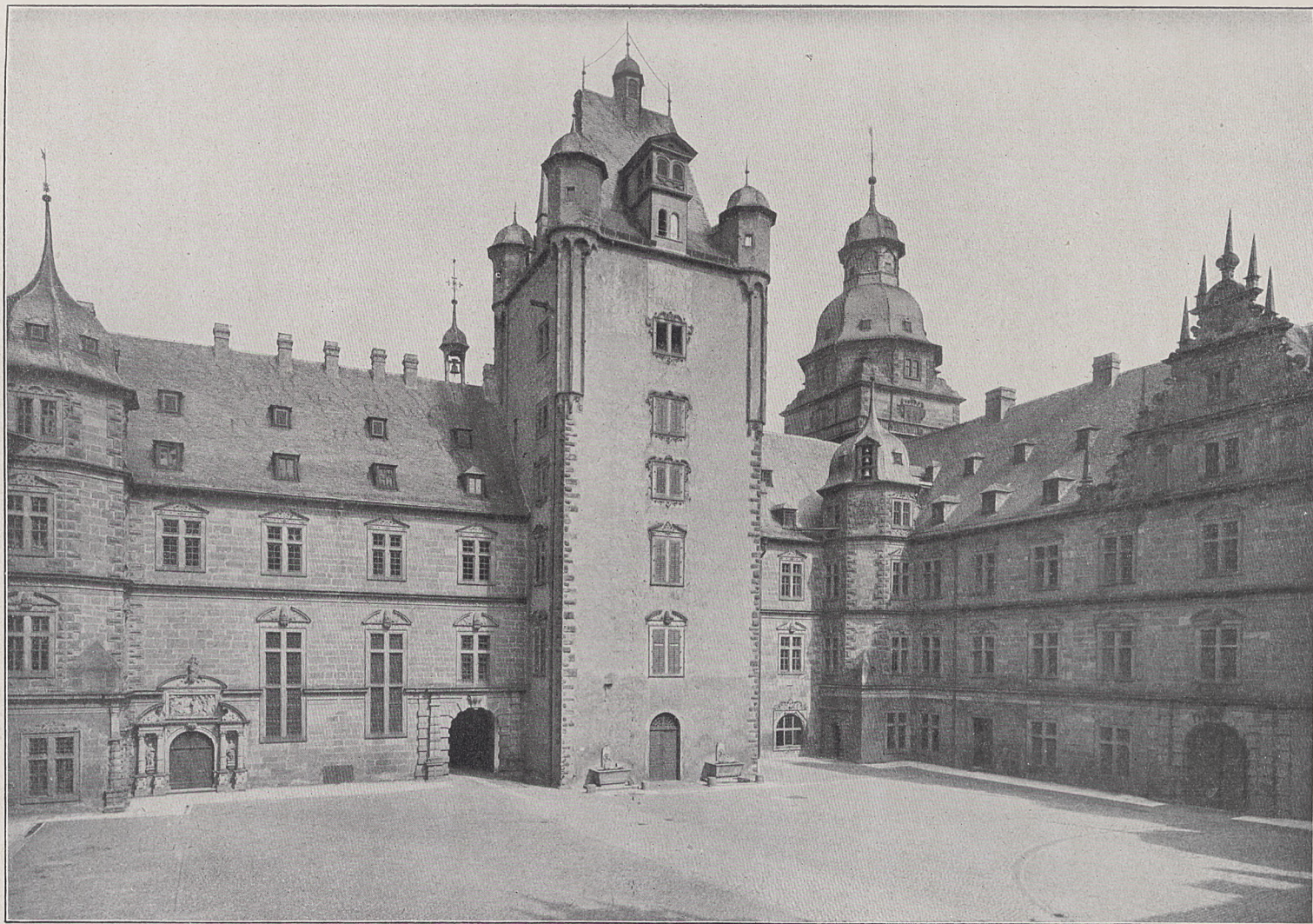
Kurmainzisches Schloß Aschaffenburg. Zinnenhof. Der mittlere Turm noch aus d. 15. Jahrh. von dem 1552 zerstörten älteren Schlosse.
