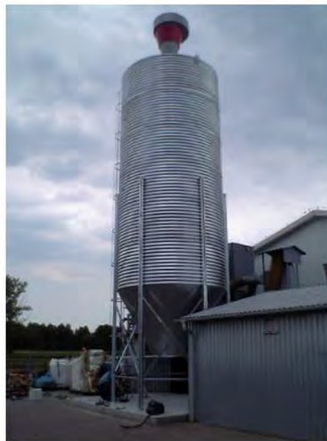
Rys. 1.1. Widok konstrukcji silosu z blachy falistej a) z żebrami na całej wysokości płaszcza b) z płaszczem częściowo uźebrowanym [65]
