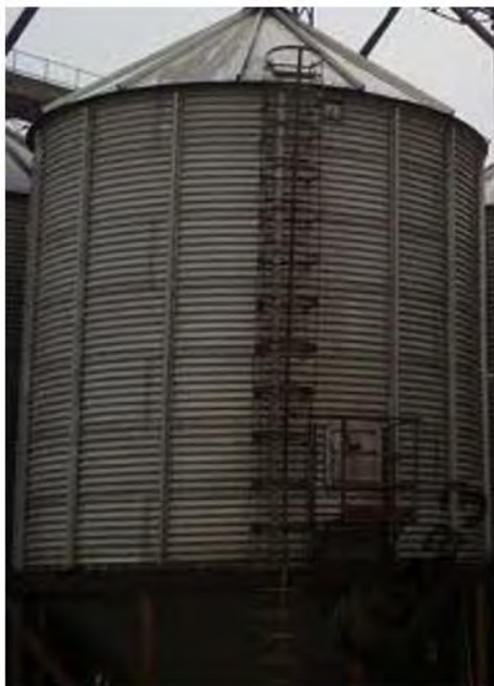
Rys. 1.1. Widok konstrukcji silosu z blachy falistej a) z żebrami na całej wysokości płaszcza b) z płaszczem częściowo uźebrowanym [65]
