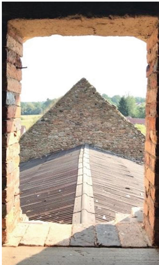
Il. 3. Tymczasowy dach nad nawą, widok z okna wieży (fot. L. Włochyński, sierpień 2018)
