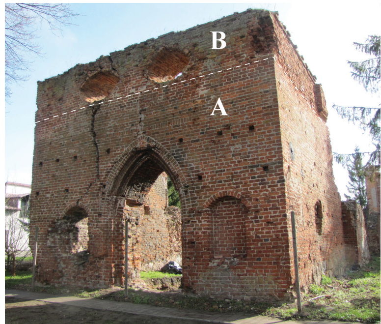
II. 7. Wieża kościoła we Wocławach. Widok od południowego zachodu: A – gotycka część wieży, B – barokowa nadbudowa wieży (fot. T. Jądzewski, 2017)
