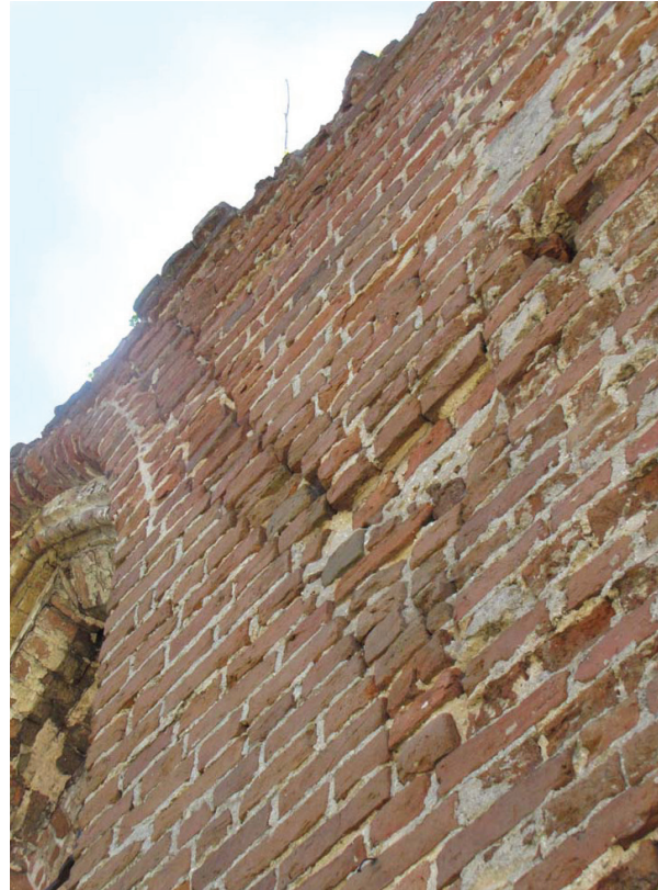
Il. 3. Zamurowana odsadzka sklepienna w prezbiterium kościoła we Wocławach (fot. T. Jażdżewski, 2017)
