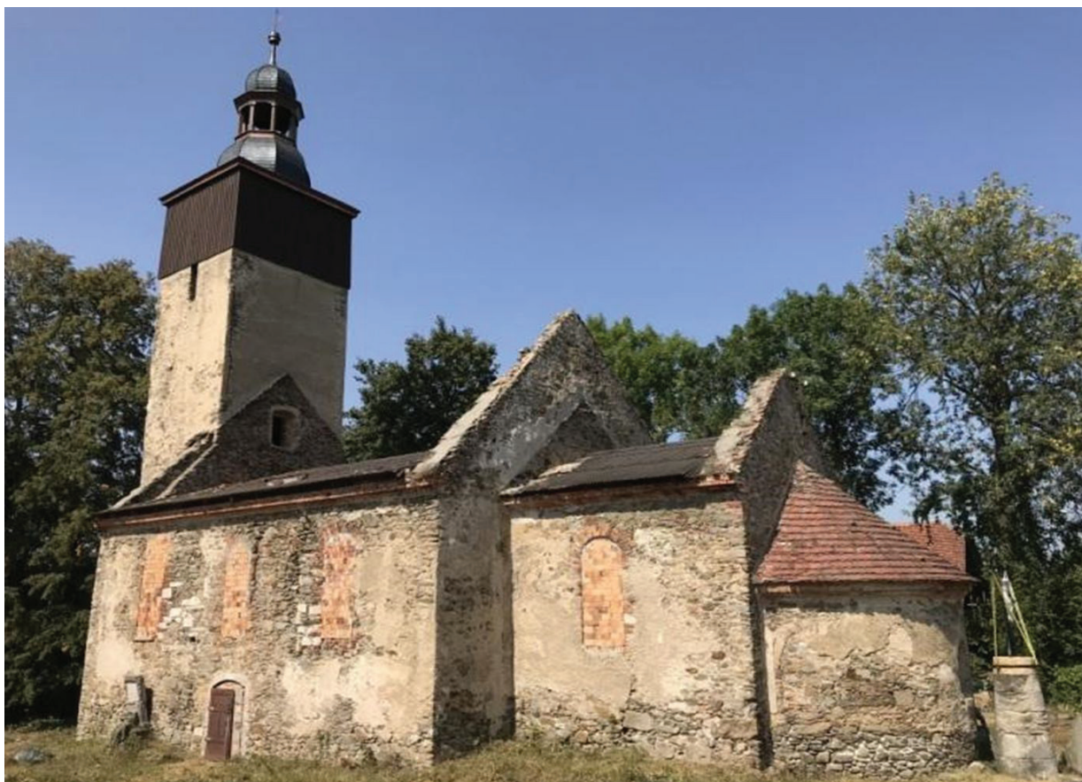
Il. 1. Ruina kościoła NMP w Kościelnikach Średnich. Widok ogólny od południowego wschodu (fot. I. Krawiec, sierpień 2018)
