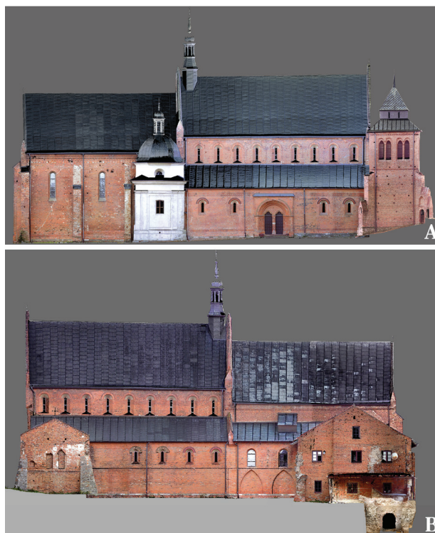
Il. 6. Sandomierz, kościół św. Jakuba i klasztor dominikanów. Rzuty ortogonalne wygenerowane ze spójcjonowanej geodezyjnie chmury punktów: elewacji północnej (A) i południowej ze ścianami szczytowymi klasztoru, z odsłoniętym fragmentem ściany południowej piwnicy o jednym filarze (B) (oprac. A. Gołębniak, I. Żyła)
