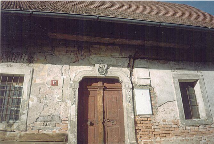
17. Drzwi wejściowe do budynku (zdj. F. Drejer)
