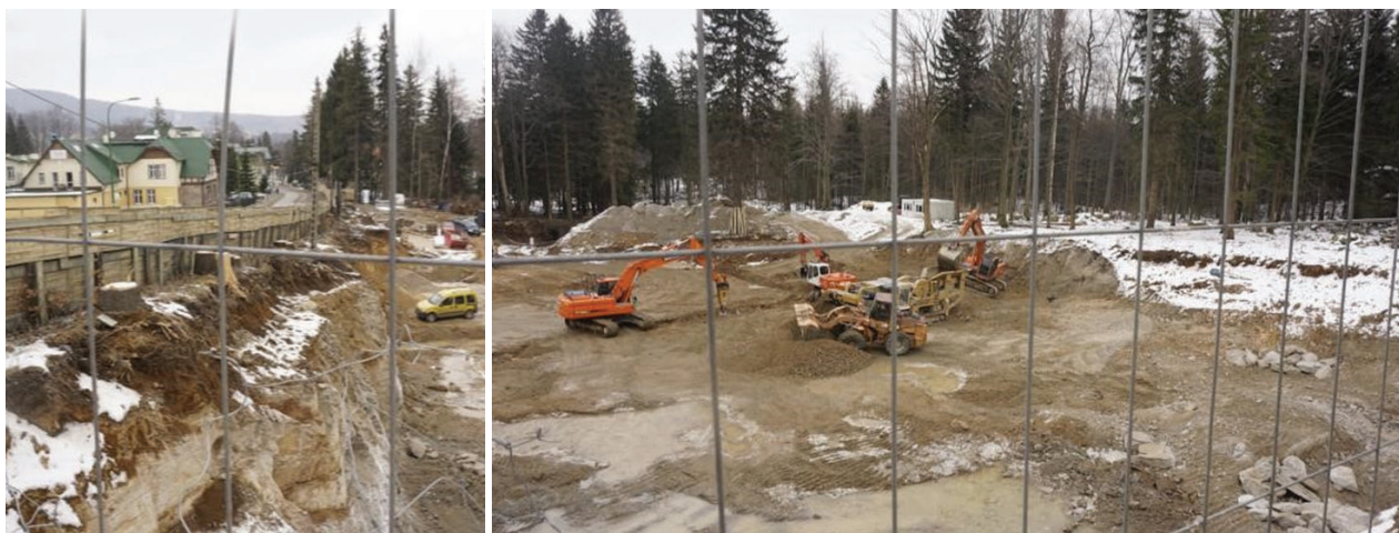
Il. 9. Szklarska Poręba, ul. Kilińskiego, teren budowy apartamentowca (fot. A. Wojtas-Harań, 2018)
