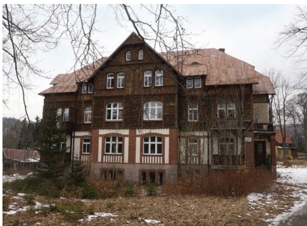
Il. 8. Szklarska Poręba, budynek przy ul. Kilińskiego 8, elewacja południowa (fot. A. Wojtas-Harań, 2018)
