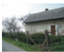
Fot. 59. Opuszczony budynek mieszkalny o dachu krytym dachówką eternitową, ul. Bema 6.
