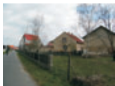
Rys. 9 Budynki ustawione szczytowo
