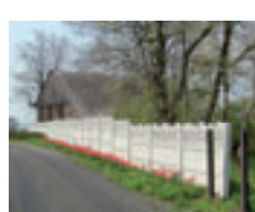
Fot. 161. Ogrodzenie betonowe przy drodze prowadzącej do posesji przy ulicy Bema 4.
