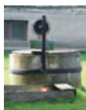
Fot. 230. Studnia, ul. Świerczewskiego 13
