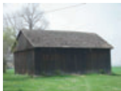
Fot. 8. Drewniana stodoła sprzed 1945 r. przy skrzyżowaniu ulic Odrzańskiej i Bema.
