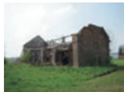
Fot. 53. Ruina budynku gospodarczego, Niedaleko posesji przy ul. Odrzańskiej 33.
