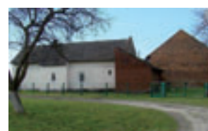
Fot. 62. Budynki mieszkalny o dachu dwuspadowym, gospodarcze o dachu jedno- i dwuspadowym o nachyleniu 45°, ul. Odrzańska 23.
