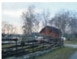
Rys. 28 Nowopowstały budynek mieszkalny.
