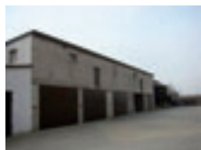
Fot. 11. Budynek gospodarczy wybudowany po 1980 r., ul. Świerczewskiego 3.
