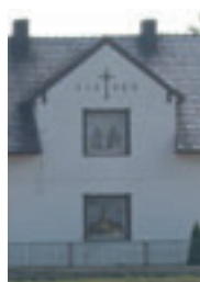
Fot. 118. Facjatka z wyeksponowanym krzyżem i datą powstania domu, ozdobne drewniane obramienia okien, ul. Odrzańska 33.
