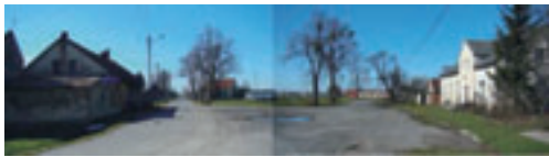
Fot. 290. Rozjazd ulic Odrzańskiej i Długiej, widok na „Rynek”.
