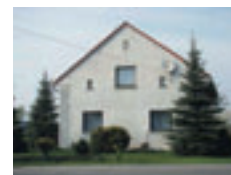
Fot. 14. Ustawienie szczytowe budynku mieszkalnego, ul. Odrzańska 18.
