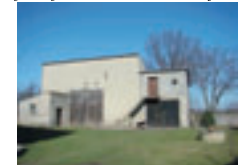
Fot. 10. Budynki gospodarcze z lat 1945-1980, ul. Długa 10.
