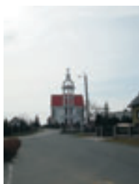
Rys. 39 Widok na kościół od strony ul. Wiejskiej
