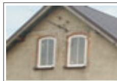
Okno zamknięte łękiem
