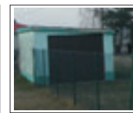
Rys.51 Garaż na ul. Wiejskiej
