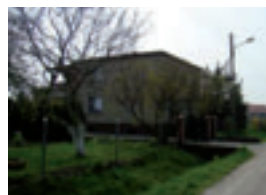
Fot. 157. Ogrodzenie z siatki, ul. Odrzańska 31.
