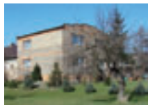
Fot. 81. Budynek mieszkalny z lat.70., ul. Polna.
