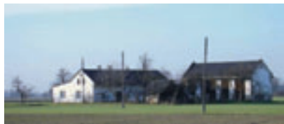
Fot. 15. Charakterystyczny układ zabudowy zagrodowej; budynek mieszkalny ustawiony kalenicą, a gospodarcze szczytem, tworzą literę L – jest to przykład prawidłowego usytuowania budynków na działce siedliskowej, ul. Długa 25.
