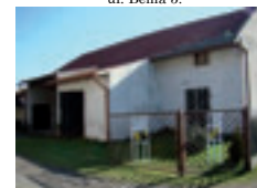
Fot. 174. Ażurowa metalowa brama i furтка, ul. Polna 2.
