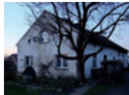
Fot. 48. Budynek mieszkalny w średnim stanie technicznym, ul. Odrzańska 20.
