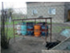
Fot. 104. Punkt wymiany butli gazowych przy domu mieszkalnym, ul. Długa 4.
