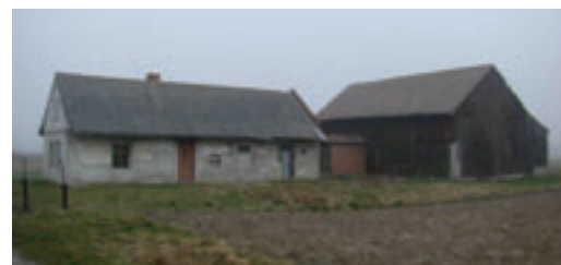
Fot. 60. Opuszczony budynek mieszkalny pokryty płytą eternitową i budynki gospodarcze kryte dachówką ceramiczną, ul. Odrzańska 46.
