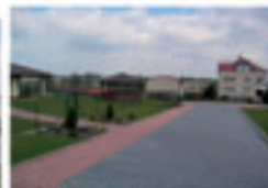
Fot. 2 Nowo wybrukowana nawierzchnia
