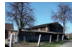
Fot. 164. Ogrodzenie mieszane: betonowe bielone słupy i metalowa siatka, Jama 13.
