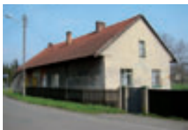
Fot. 71. Budynek mieszkalny połączony z gospodarczym, ul. Odrzańska 9.
