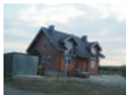
Rys. 29 Nowopowstały budynek mieszkalny.
