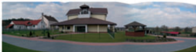
Fot. 1 Panorama terenu przy Centrum Kształcenia. Widok na elewację wschodnią
