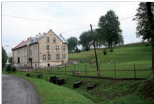
Ryc. 104. Miejsce projektowe obok szkoły – brak realizacji (jesień 2008)
