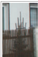
Rys. 65 Podpora na pniąca między oknami
