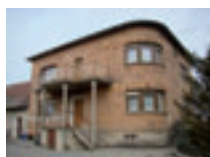
Fot. 80. Nietypowy budynek mieszkalny, ul. Świerczewskiego 3.
