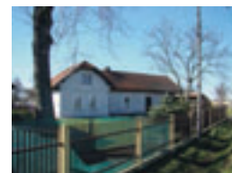
Fot. 151. Ogrodzenie mieszane, betonowe słupy z metalowymi przęslami przypominającymi drewniane sztachety, ul. Odrzańska 7 – pozytywny przykład.
