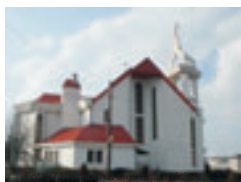
Rys. 37 Wschodnia elewacja kościoła
