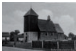
Kościół w trakcie budowy.
