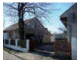
Fot. 171. Drewniana brama, ul. Długa 1.
