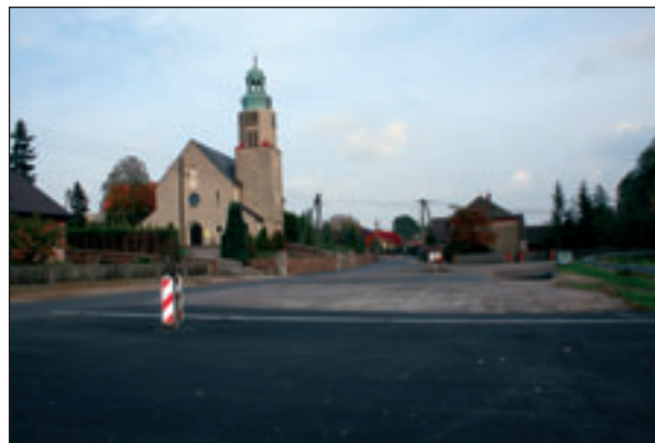
Ryc. 24. Zagospodarowanie w roku 2008 – nowa nawierzchnia asfaltowa Fig. 24. Management in 2008 – new asphalt surface
