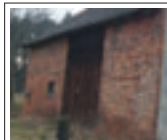
Rys.47 Stodola na ul. Wiejskiej
