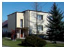
Fot. 61. Dach płaski, ul. Odrzańska 4.
