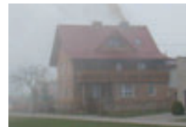
Fot. 64. Dach wielospadowy, ul. Świerczewskiego 5.
