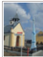
Rys. Kapliczka po remoncie
