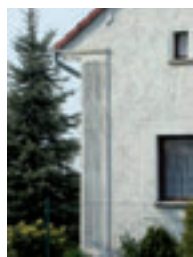
Fot. 117. Pilaster w szczycie budynku, ul. Odrzańska 18.
