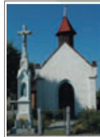
Rys. Widok kapliczki od frontu. Zdjęcie wykonane przed remontem
