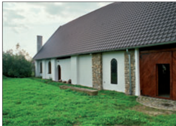
Ryc. 14. Teren opracowania – brak realizacji (stan wrzesień 2008) Fig. 14. Area of the study – lack of realization (state September 2008)
