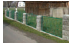
Fot. 153. Ogrodzenie mieszane, przęsla ciemnozielone – kolor stosowany na Opolszczyźnie, ul. Świerczewskiego 14.
