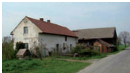
Fot. 54. Budynek mieszkalny kryty dachówką karpieńską, budynki gospodarcze dachówką cementową, ul. Długa 23.
