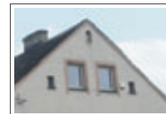
Jedno z ciekawszych obramień okiennych. Obramienie schodzi poniżej parapetu, tworząc okapnik
