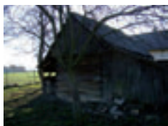
Fot. 93. Drewniany spichlerz wart odnowienia, ul. Długa 25.
