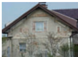
Fot. 121. Ozdobne obramienia okienne, wymiana okien bez zachowania poprzednich wymiarów i podziałów, ul. Bema 8.
