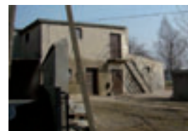
Fot. 66. Budynek gospodarczy o dachu płaskim i budynek mieszkalny o dachu jednospadowym o nachyleniu 30°, ul. Odrzańska 49.
