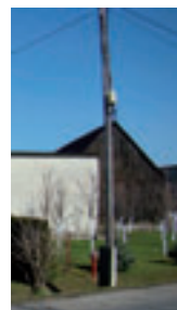
Fot. 228. Elementy infrastruktury nadziemnej, ul. Długa.
