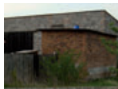
Fot. 97. Mały budynek gospodarczy, ul. Długa 4.
