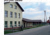
Fot. 4 Budynek od strony ul. - Wjazd
