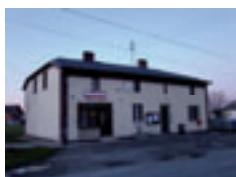
Fot. 103. Sklep spożywczo-przemysłowy, punkt wymiany butli gazowych, ul. Odrzańska 22.
