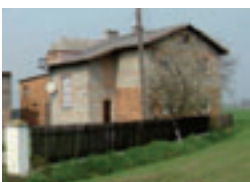
Fot. 84. Negatywny przykład budynku mieszkalnego, ul. Długa 18.
