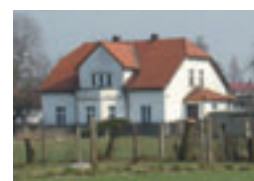
Fot. 63. Dach naczółkowy, ul. Odrzańska 11.
