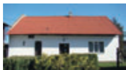
Fot. 56. Dach budynku mieszkalnego kryty blachodachówką, ul. Odrzańska 15.
