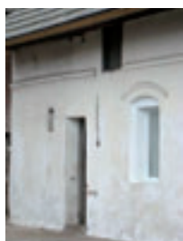
Fot. 119. Detale domu sprzed 1945 roku: profilowany gzyms, lukowe nadproże nad oknem, ul. Odrzańska 24.
