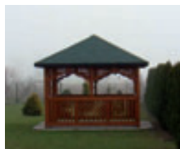
Fot. 178. Drewniana altana, ul. Świerzewskiego 6.
