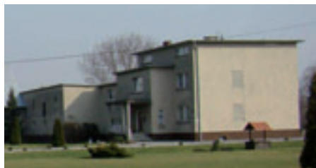
Fot. 55. Budynek mieszkalny połączony z budynkami gospodarczymi o dachach przekrytych papą, ul. Odrzańska 13.
