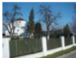
Fot. 150. Ogrodzenie mieszane, bielone słupy z drewnianymi przęslami, ul. Odrzańska 2 – zalecany typ ogrodzenia godny naśladowania.
