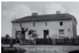
Należący do rodziny Ritzka budynek sklepu i piekarni, do dziś znajduje się tu sklep.
