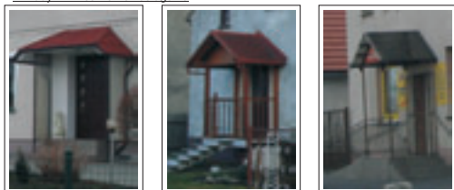
Daszki przed wejściami do budynków - prosta forma, wykonywane z różnych materiałów
