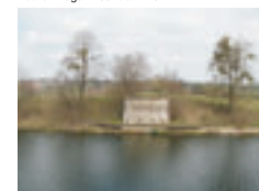
Fot. 7 Zerwany most na końcu ulicy Kanałowej
