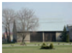
Fot. 58. Budynek gospodarczy kryty blachą falistą, ul. Odrzańska 13.
