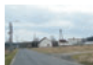
Rys. Duże zagęszczenie słupów elektrycznych
