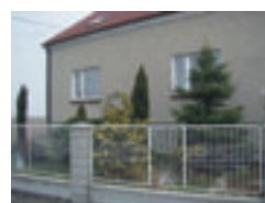
Fot. 152. Ogrodzenie mieszane, betonowe słupy z metalowymi przęslami, ul. Świerczewskiego 2.
