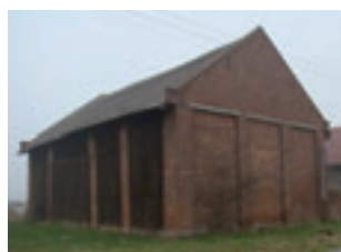
Fot. 140. Dawna stodoła ze skromnym detalem architektonicznym, widoczne lizeny w ścianie szczytowej, ul. Odrzańska 45.
