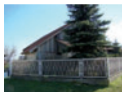
Fot. 158. Ogrodzenie z metalowych przęsel na podmurówce, ul. Polna 4.
