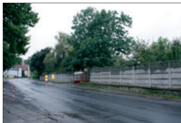
Ryc. 8. Betonowe ogrodzenie – brak realizacji (stan na 2008) Fig. 8. Concrete enclosure, lack of realization (2008)
