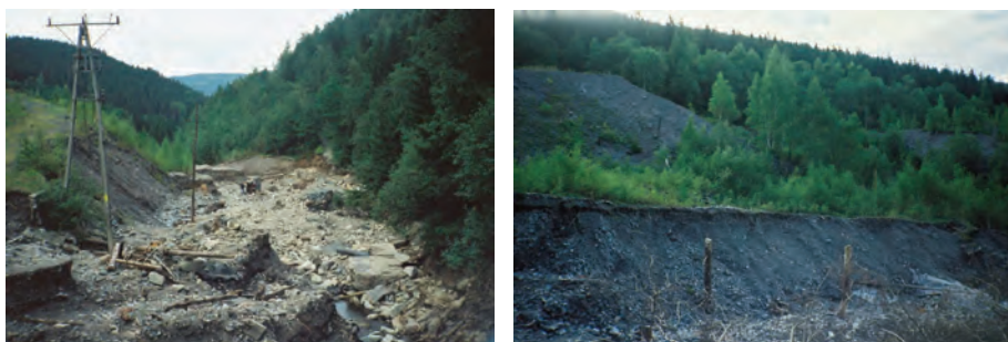
Ryc. 30. Rozmyte przez powódź pozostałości hałdy pokopalnianej według stanu z 11.09.1997 r. (fot. R. Borzęcki)
