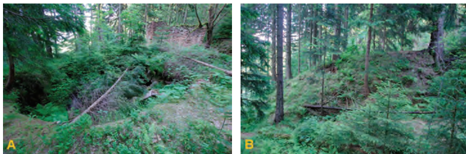
Ryc. 31. Obiekty ponad sztolnią nr 19: A – szyb wentylacyjny, zapadlisko szybu i ruiny wentylatora, B – hałda (stan z 14.06.2017 r., fot. D. Wójcik) Fig. 31. Objects above adit No 19: A – air shaft, shafthead (subsided) and fanhouse remains, B – tailing (photo 14/06/2017, D. Wójcik).
