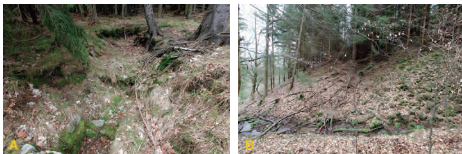
Ryc. 7. Sztolnia nr 12: A – zapadnięte okno, B – hałda (stan z 9.04.2017 r., fot. D. Wójcik)
