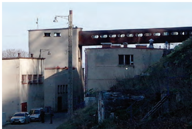
Ryc. 13. Budynek młyna kulowego według stanu z 1.04.2017 r. (fot. D. Wójcik)
