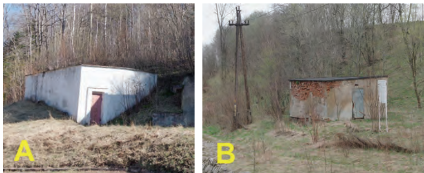
Ryc. 17. Budynek zbiornika wody przemysłowej (A) i pompowni nad rzeką Jedlicą (B) (obie ryciny – stan z 1.04.2017 r., fot. D. Wójcik)
