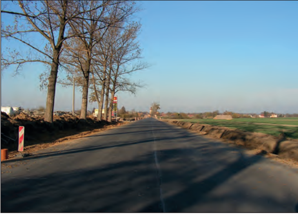
Ryc. 9. Widok w trakcie modernizacji drogi nr 401 (fot. O. Mycak, 2010)
