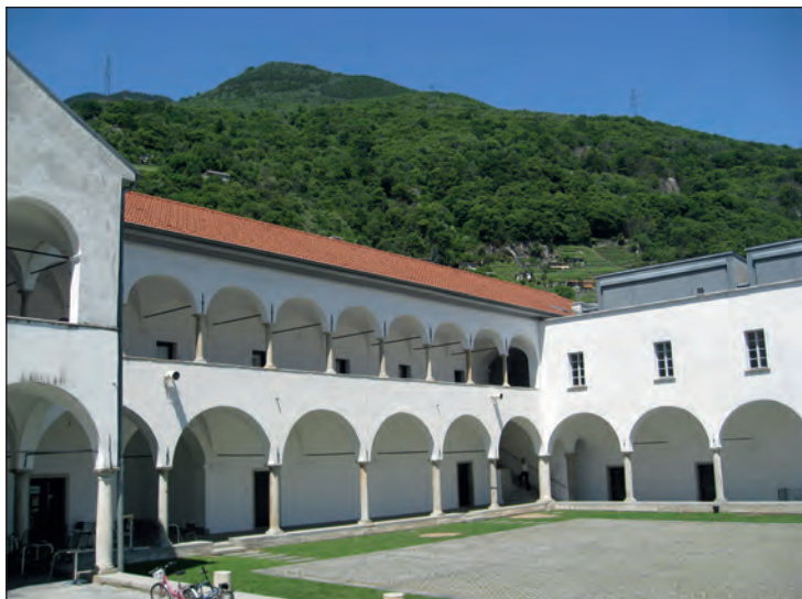
Ryc. 3. Budynek klasztorny po adaptacji na gimnazjum (fot. A. Böhm)
