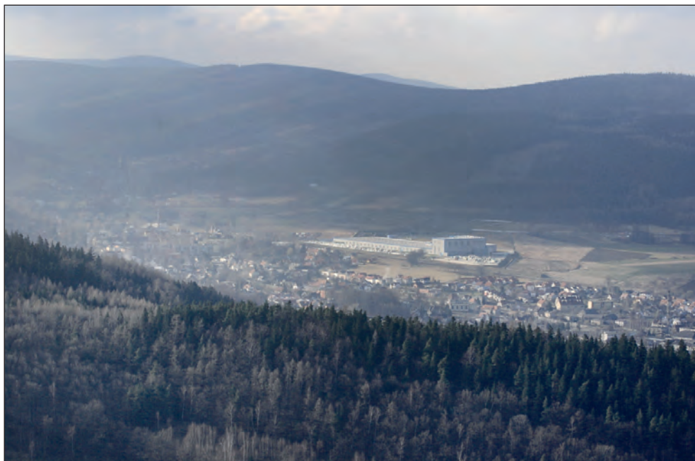
Ryc. 1. Hala firmy Ceramika Marconi w Piechowicach widoczna z punktu widokowego na zamku Chojnik.
