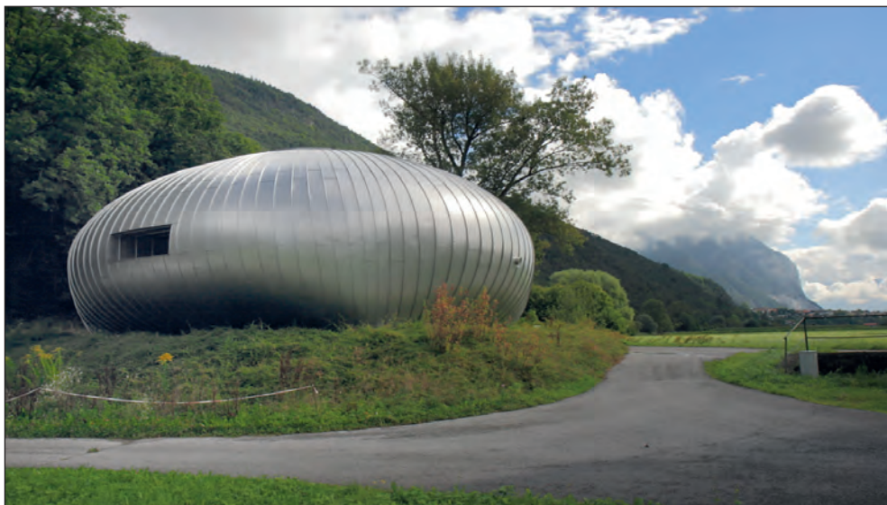
Ryc. 3. Budynek elektrowni wodnej tzw. Power Plobb w dolinie rzeki Inn. Konkurs architektoniczny wygrał i projekt zrealizował arch. Michael Prachensky (fot. M. Baborska-Narożny)
