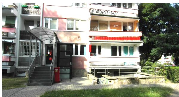
Rys. 109. Winda do urzędu pocztowego (zdj. autor)
