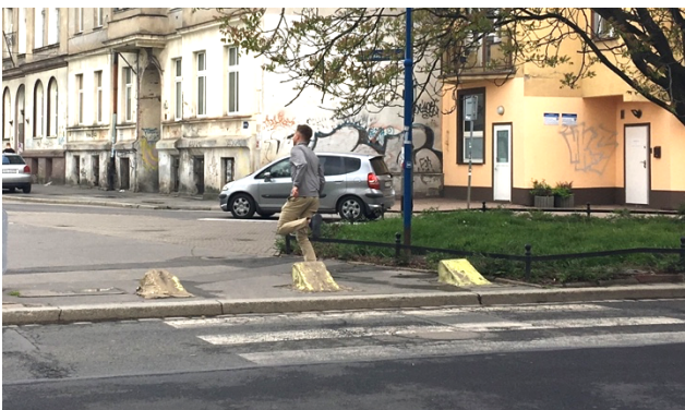
Rys. 46. Przejście dla pieszych z bardzo wysokim krawężnikiem oraz mało widocznymi, niskimi przeszkodami w postaci słupków. Ul. Komuny Paryskiej, Wrocław (zdj. autor)
