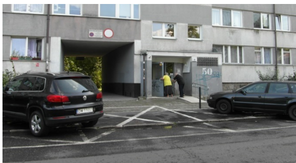
Rys. 112. Przejście bramne i wejście do bud. (zdj. autor)
