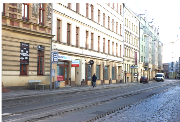
Rys. 49. Przystanek tramwajowy bez wiaty i podwyższenia jezdni, brak miejscowego obniżenia krawężnika. Szczytnicka, Wrocław (zdj. autor)
