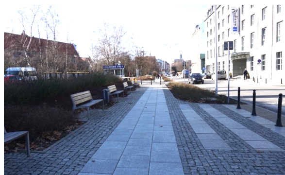
Rys. 43. Chodnik z płyt granitowych, po bokach pola uwagi z kostki granitowej, mała architektura (ławki, kosze) odsunięta za pole uwagi, chodnik oddzielony od drogi pasem zieleni. Ulica Jana Ewangelisty Purkyniego, Wrocław, realizacja 2014 rok (zdj. autor)
