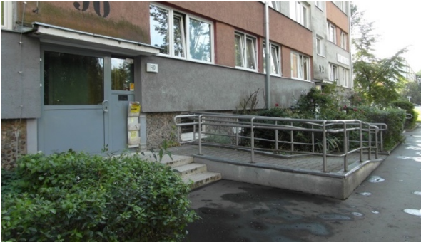
Rys. 114. Rampa przed wejściem do budynku (zdj. autor)
