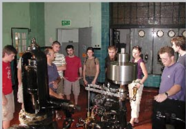
W elektrociepłowni wodnej w Luboszewie
