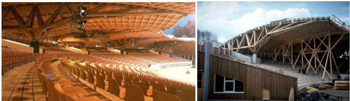
Rys. 5.160. Trybuny stadionu w Altusried, Architektura: Mohr, Altusried. Konstrukcja IEZ Natterer GmbH mit Ingenieurbüro Bertsche. Realizacja: 1999, [333].
