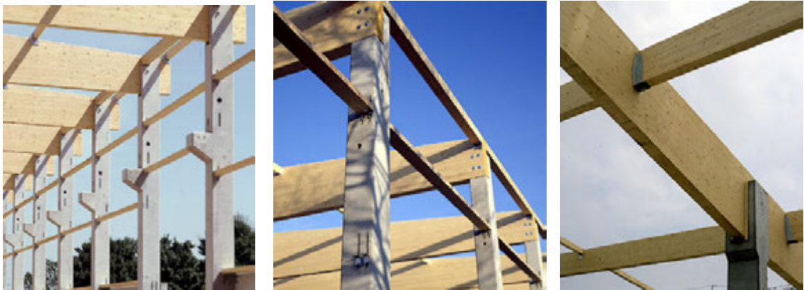
Rys.7.11. Schemat poarcia belki z drewna klejonego na słupie żelbetowym [335]. Posadowienie belki z drewna klejonego na słupie żelbetowym bez blach stalowych za pomocą śrub. Głowice słupów formuje się do kształtu, który umożliwi osadzenie belki bez potrzeby stosowania blach. Trzeba pamiętać o tym, żeby powierzchnie żelbetu i drewna odizolować od siebie stosując podkładki z folii, gumy lub teflonu, przy konieczności uzyskania przesuwu [335].
