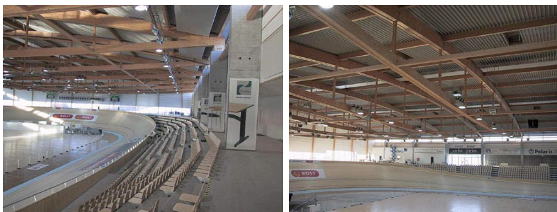
Rys. 5.86. Bellerup Superarena, Kopenhaga. Konstrukcja uległa zawaleniu w 2004, [329].
