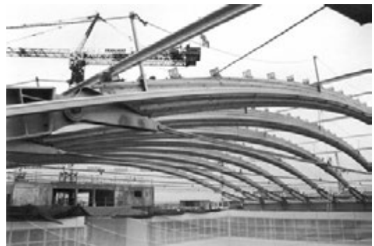
Rys.7.15. Detal podparcia. Renault Technocenter w La Ruche, Francja, [6].
