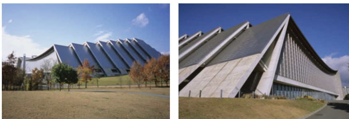
Rys. 5.132. Hala olimpijska łyżwiarstwa szybkiego w Nagano, Japonia. Architektura: Kajima, [342].
