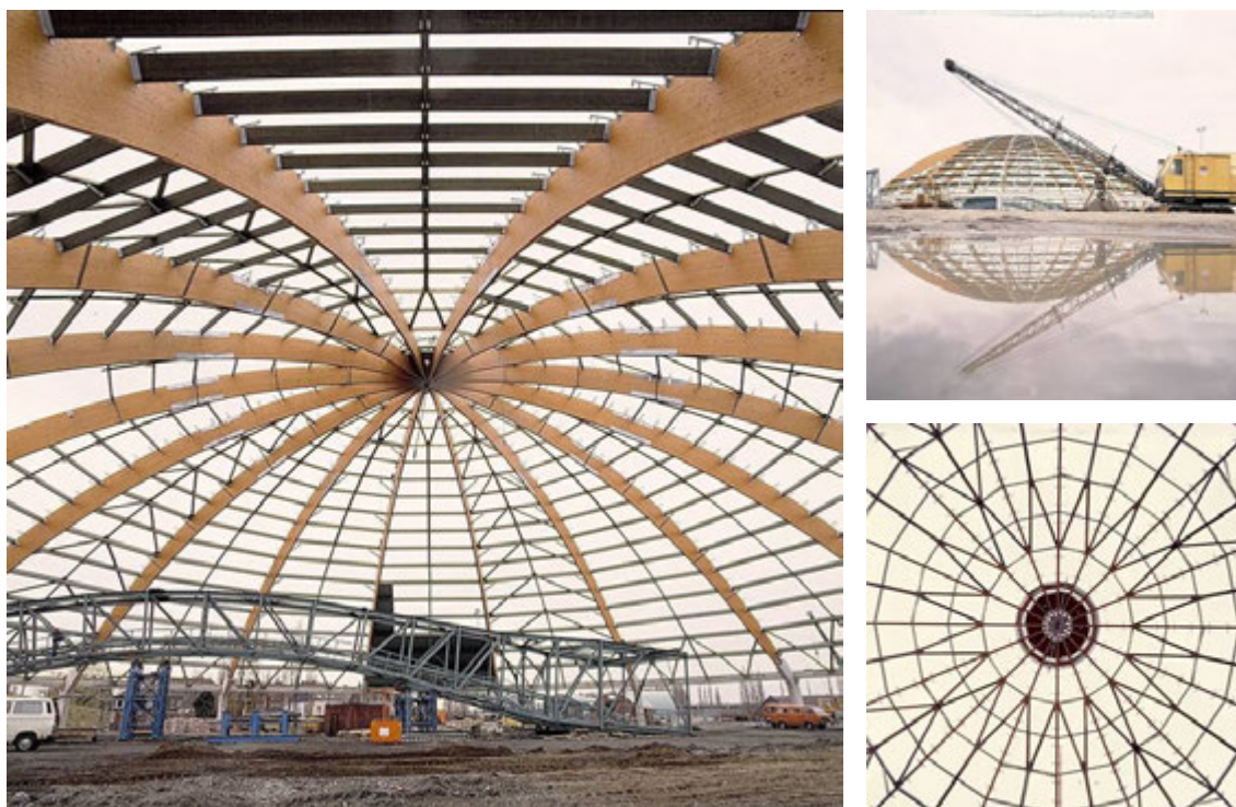
Rys. 5.118. Magazyn węgla w Walsum, Niemcy. Architektura: HIPP. Konstrukcja: Brueninghoff, Heiden, Średnica 100 m, wys. 27. Realizacja: 1987, [335].
