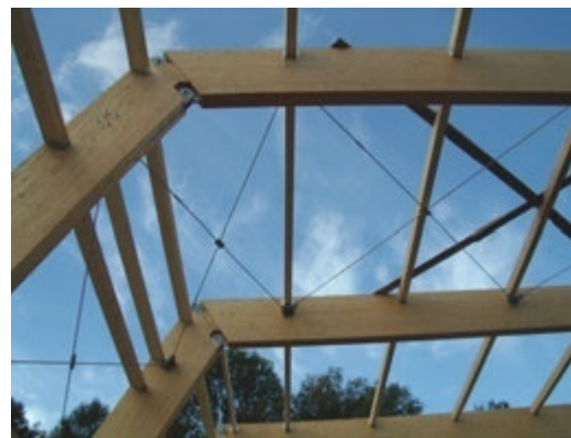
Rys. 5.69. Złącze podporowe na stopie stalowej wraz z prętem stalowym na stężenie ścian. Złącze kalenicowe, [335].
