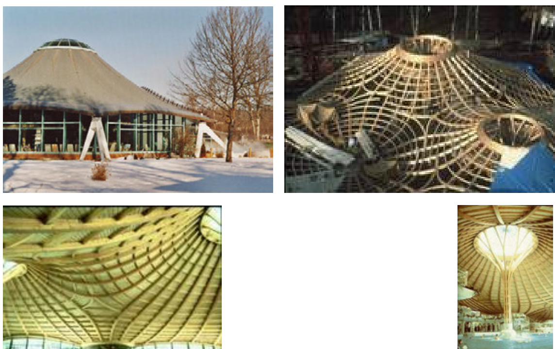
Rys. 5.131. Siatkowa struktura dachu krytej pływalni Solebad Bad Duerheim, Niemcy. Architektura: Geier + Geier, [323].
