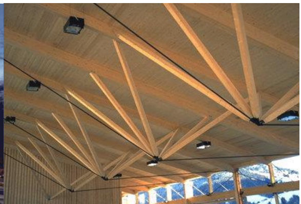
Rys. 5.43. Kratownica hybrydowa konstrukcji kościoła w Łodzi, [332].
