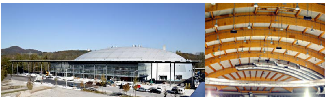
Rys. 3.7. Hala sportowa w Salzburgu. Wymiary: 118 x 120 m. Dźwigary o wymiarach: 24 x 217 cm, [307].
