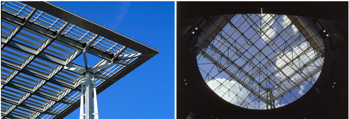
Rys. 5.54. Lloyd D. George United States Courthouse, Las Vegas, Architektura: Yazdani Studio Cannon Design. Realizacja: 2000, [356]
