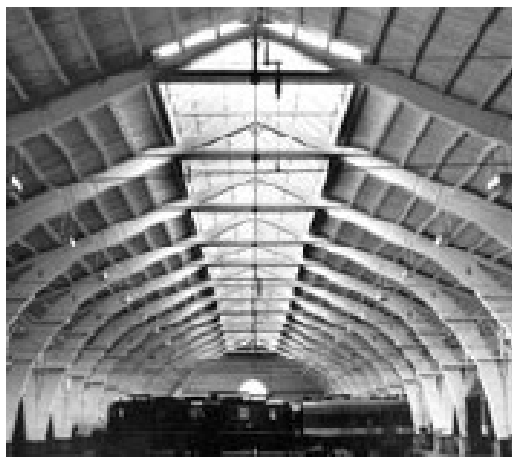
Rys.1.4. Jedno z pierwszych zastosowań drewna klejonego Schiebebühnenhalle, Stuttgart 1915. Otto Hetzer AG, Weimar [251].
