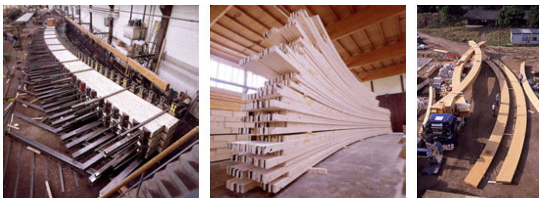
Rys. 5.5. Dźwigar łukowy podczas klejenia. Transport i rozładunek dźwigarów łukowych na placu budowy. Dźwigary łukowe przed obróbką, [335].
