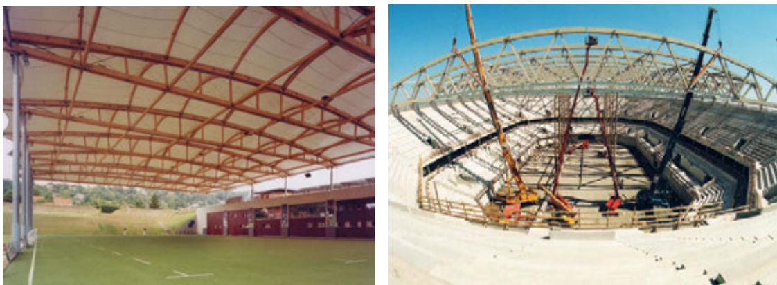
Rys. 5.88. Przekrycie boiska do rugby; Fougerolle we Francji, [338].
