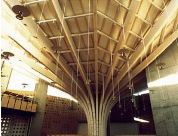
Rys. 5.67. Rugby Church w Erritsø, Dania. Konstrukcja w kształcie parasola (lub drzewa) wykonana z ram z drewna klejonego o rozpiętości 32m i wysokości 13 m, [329].
