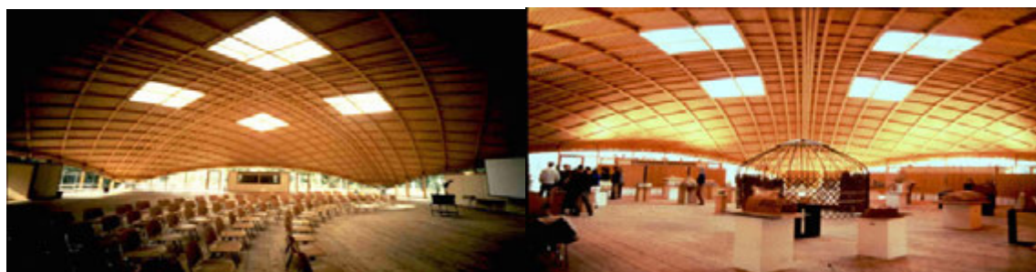
Rys. 5.155. Polydome w Lozannie. Architektura Badic et Associates, Morges. Konstrukcja: Bois Consult Natterer SA, Realizacja: 1990. Rozpiętość: 27 m, [333].
