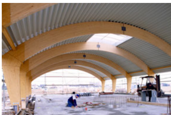
Rys. 5.66. Węzeł sztywny zrealizowany poprzez wbudowane wkładki stalowe, [335].
