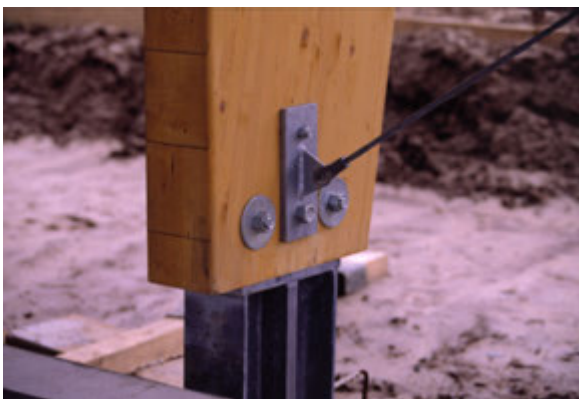
Rys. 5.69. Złącze podporowe na stopie stalowej wraz z prętem stalowym na stężenie ścian. Złącze kalenicowe, [335].
