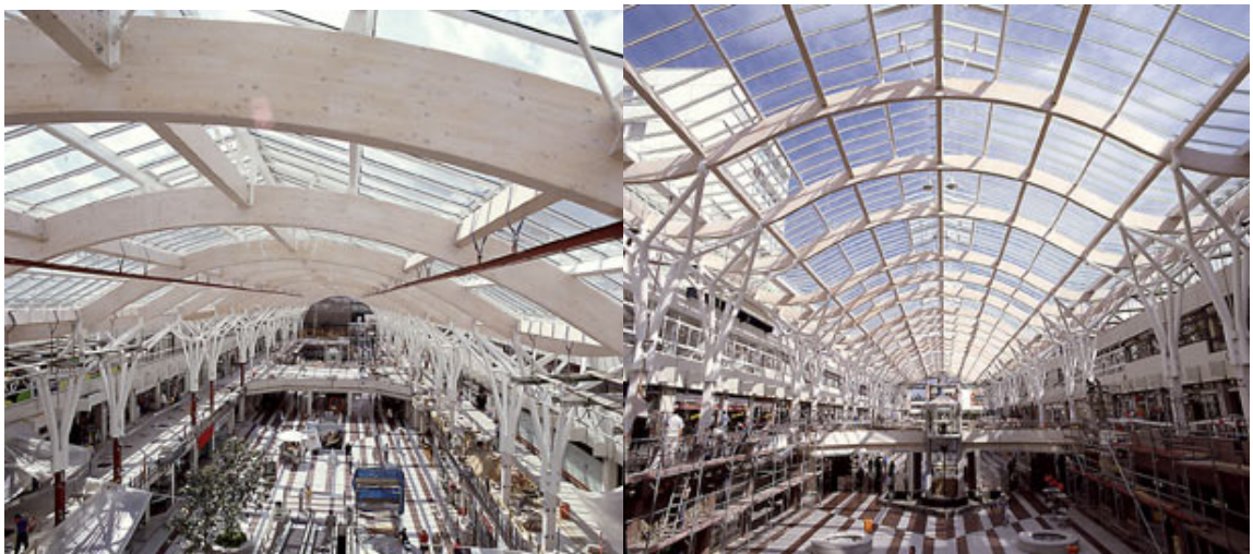
Rys. 5.78. Centrum handlowe (Nordwestzentrum), Frankfurt nad Menem, Niemcy, [335].
