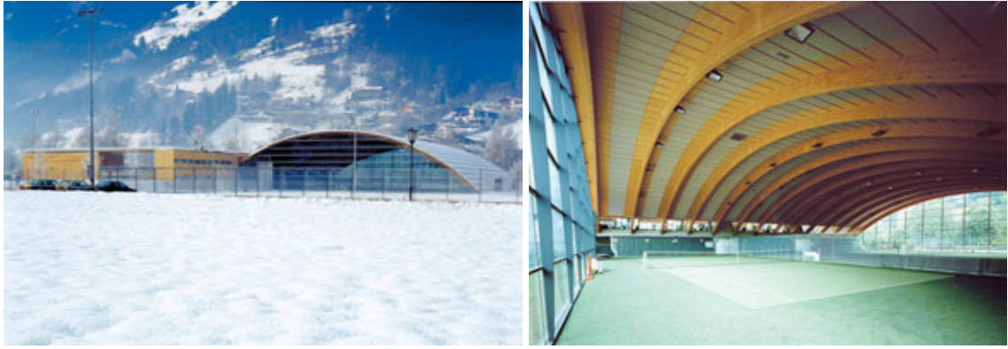
Rys. 5.98. Hala Tenisowa w Tyrolu w Austrii. Architektura: Reitter Helmut , DI. Realizacja: 1996. Rozpiętość: 40m, [321].
