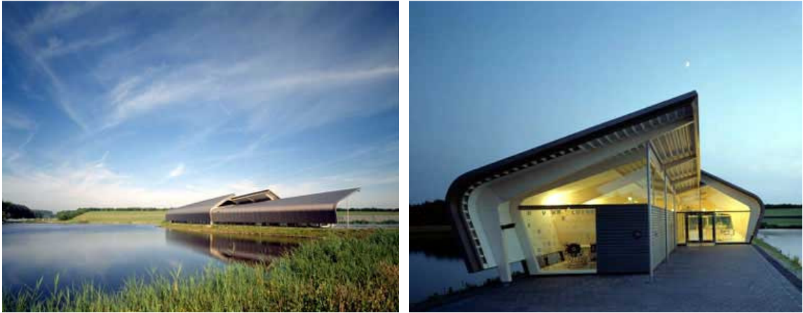
Rys. 3.62. Art Pavilion The Imagination, Zeewolde, Holandia. Architektura: René van Zuuk Architekten, [302].
