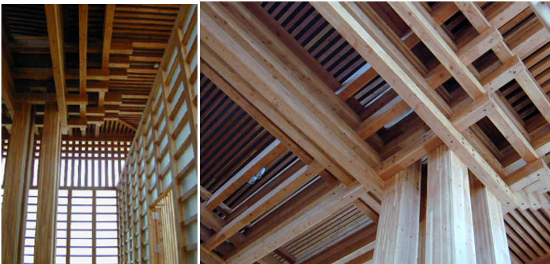
Rys. 5.58. Świątynia Komyo-ji w Saijo prefektura Ehime w Japonii. Architektura Tadao Ando. Nawiązanie do tradycyjnej techniki konstrukcyjnej daibutsu (lub tejiku). Konstrukcja ta wyróżnia się systemem wsporników, które przenoszą obciążenia z dachu na kolumny, [47].
