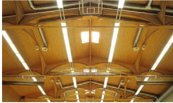
Rys. 5.11. Przykład kształtowania dźwigara poprzez wycinanie: Mehrzweckhalle Hauki-Halli, Finland. Architektura: Markku Suomela, Marita Maraharju. Konstrukcja: Bois-Consult Natterer SA, [333].
