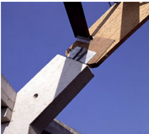
Rys.7.18. Oparcie belki z drewna klejonego na słupie żelbetowym. Głowice słupów są płasko wykończone, elementy z drewna klejonego mocuje się za pomocą blach stalowych, które są wcześniej zakotwione w przekroju żelbetowym za pomocą wklejanych lub zabetonowanych kotew, [335].
