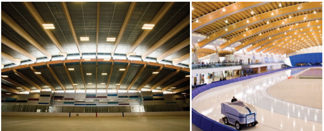
Rys. 5.96. Hala Lodowiska w Vancouver (Olimpiada w 2010), [297].
