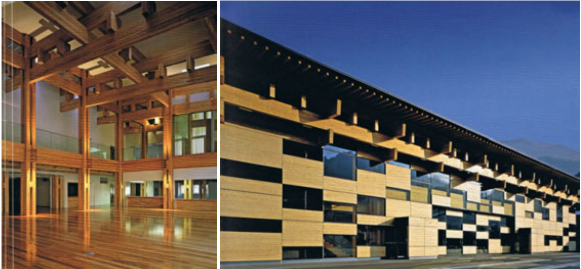
Rys. 5.56. Budynek ratusza miejskiego w Yusuhara w Japonii. Architektura Kochi Kengo Kuma & associates . Duża rozpiętość przekrycia uzyskana przez zastosowanie rusztu przestrzennego Vierendeela, z belek z drewna klejonego. Przeniesienie nietypowej konstrukcji dachu na elewację, [268].
