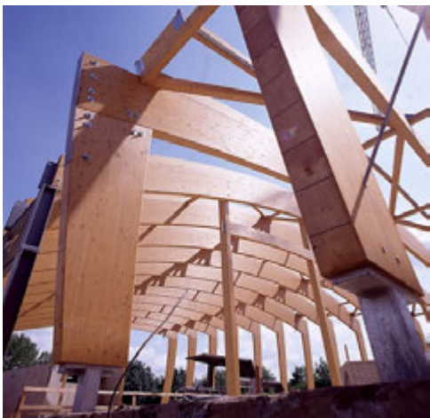
Rys.7.17. Podstawa łuku – połączenie przegubowe [335], [329].
