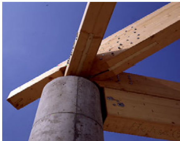
Rys.7.18. Oparcie belki z drewna klejonego na słupie żelbetowym. Głowice słupów są płasko wykończone, elementy z drewna klejonego mocuje się za pomocą blach stalowych, które są wcześniej zakotwione w przekroju żelbetowym za pomocą wklejanych lub zabetonowanych kotew, [335].
