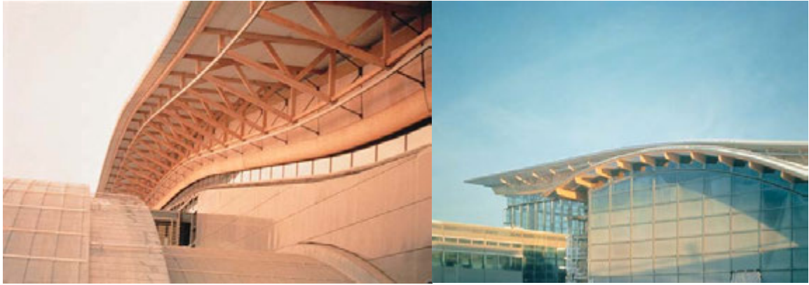
Rys. 5.76. Port Lotniczy Gardermoen w Oslo, Norwegia, Architektura:Aviaplan AS, Niels Torp, Rozpiętość: 112 m , długość: 165 m, powierzchnia dachu: 25.000 m 2 , Realizacja:1993-1998, [347].
