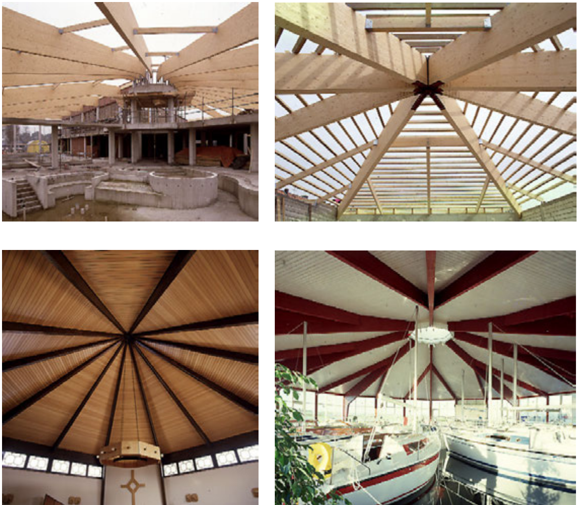
Rys. 5.31. Belki proste w układach centralnych bardzo często wykorzystuje się w obiektach na planach koła o stosunkowo niewielkiej średnicy lub w obiektach gdzie można zastosować wewnętrzną podporę, [335].
