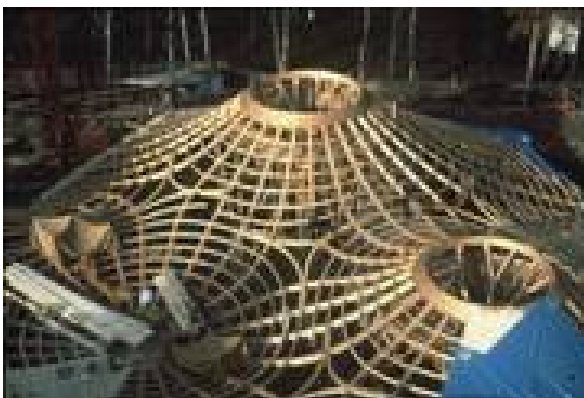
Rys. 6.6.. Siatkowa struktura dachu krytej pływalni Solebad Bad Duerheim, Niemcy , Architektura: Geier + Geier, [276]. Pajęczyna, [357].
