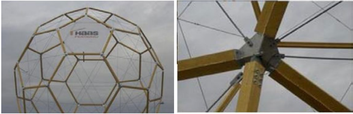
Rys.7.36. Łączniki systemowe struktur przestrzennych z drewna [331].
