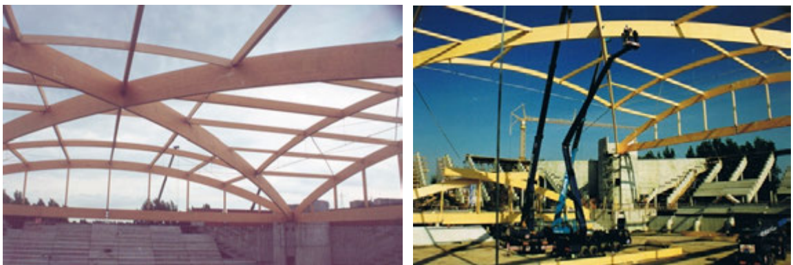
Rys. 5.100. Hala sportowa w Bydgoszczy. Architektura: Moduł, Zenon Nowacki. Konstrukcja dachu: Lilleheden A/S. Rozpiętość: 78 m. Realizacja: 2000, [329].
