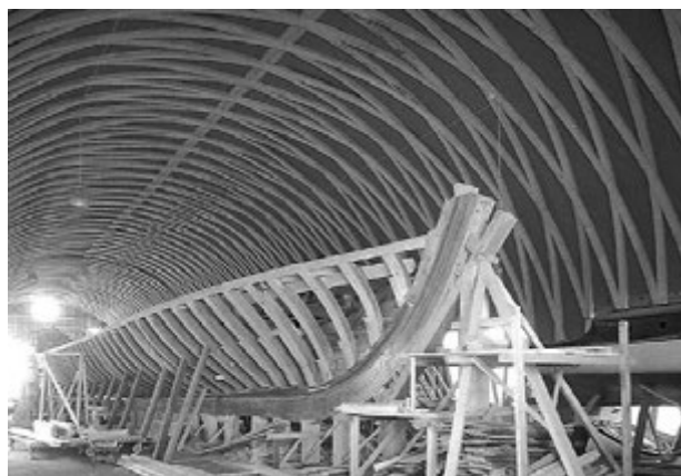
Rys. 5.140. Hala wystawowa w Morges. Rozpiętość 20 m, długość – 60 m, wysokość – 12 m, [333].
