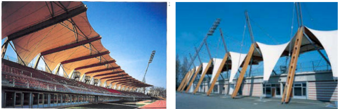
Rys. 5.159. Trybuny Stadionu w Erfurcie. Architektura: Orlich Zimmermann. Konstrukcja Oswald & Fessler, [326].
