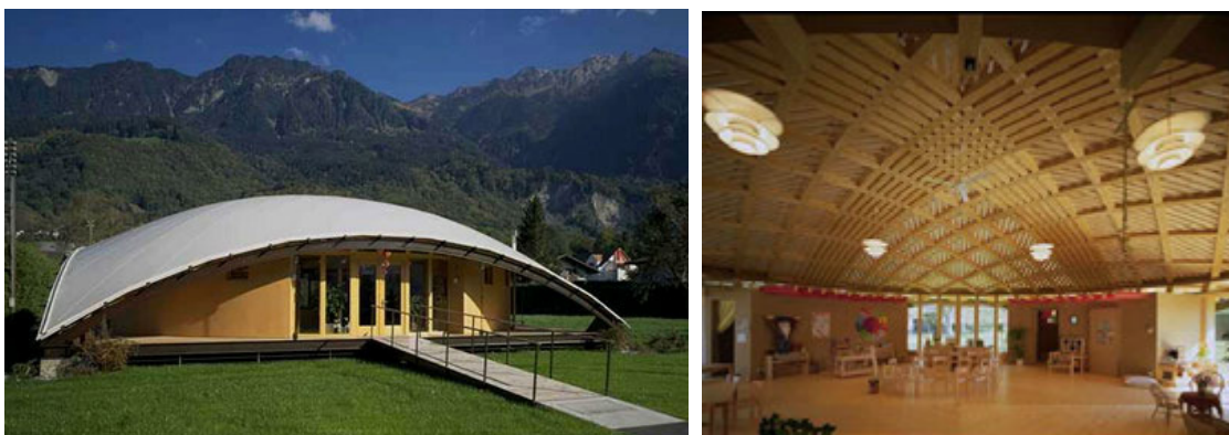
Rys. 5.152. Kindergarten Triesen w Finlandii, Architektura: Effeft AG, Konstrukcja: Bois-Consult Natterer SA. Realizacja 1998. Rozpiętość 17 m, [333].
