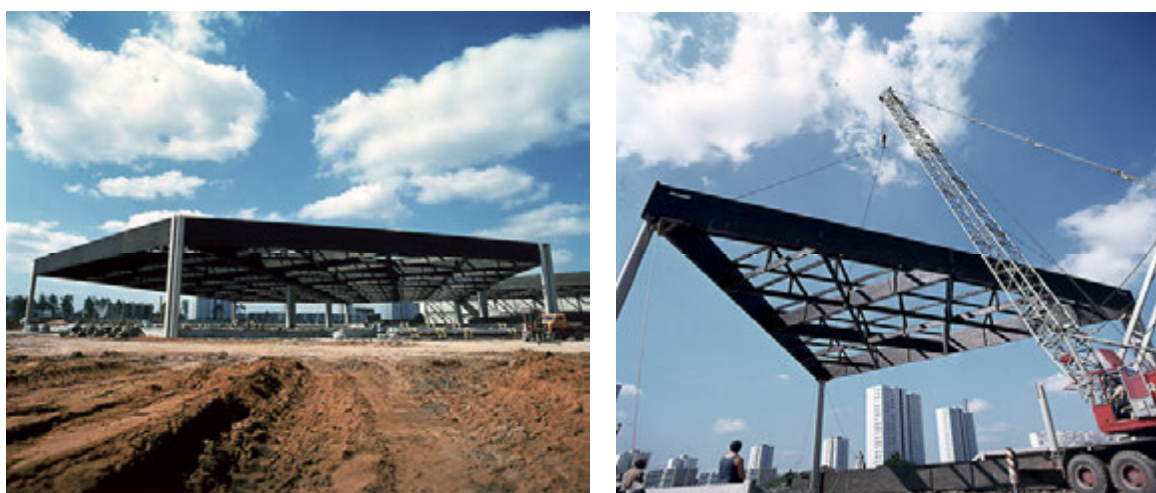
Rys. 5.52. Konstrukcja rusztu o segmentach trójkątnych, [335].
