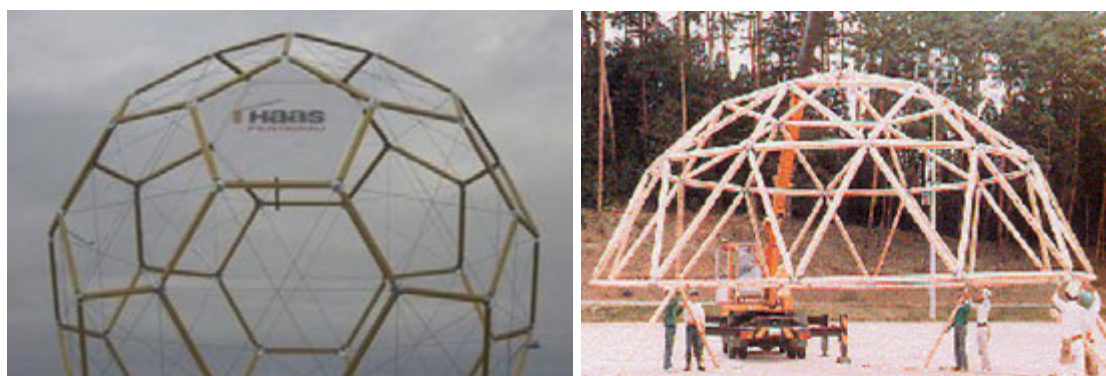
Rys. 5.112. Schematy możliwości konstruowania kopuł z drewna klejonego, Kopuły geodezyjne skonstruowane w Niemczech i w Japonii 1985 r. Schemat konstruowania kopuł geodezyjnych , [93].
