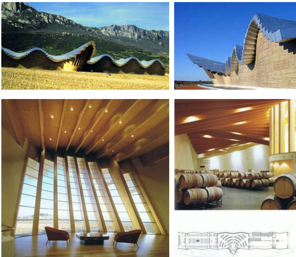
Rys. 3.17. Winnica Bodegas Ysios w Hiszpanii. Architektura: Santiago Calatrava. Efekt przesuwającej się fali o długości 196 m i rozpiętości 26 m uzyskano za pomocą sinusoidalnie rozmieszczonych prostych belek z drewna klejonego.. „Falistość” nawiązująca do pasma gór staje się tu oczywista, [72].
