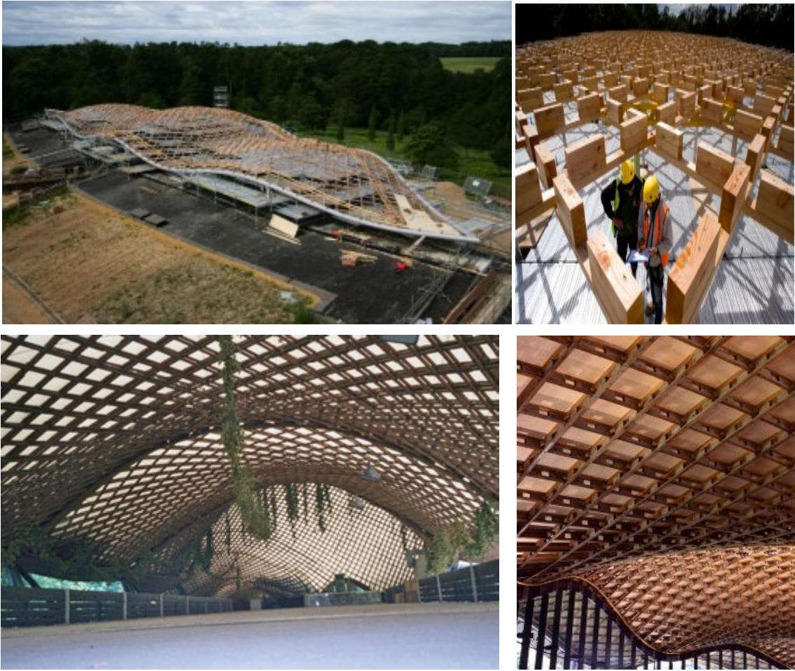
Rys. 5.145. Pawilon w Savill Garden Architektura: Glen Howells Architects, Realizacja: 2005-2006, [304].
