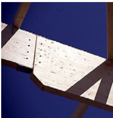
Rys. 5.28. Połączenie belki wieloprzęsłowej na tzw. złącze Gerbera, [335].
