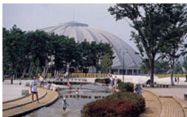
Rys. 5.116. Yamabiko Dome (SHINSHU SKY PARK) Hala wielofunkcyjna Shinshu Sky Park, Nagano Prefecture, Yamabiko w Japonii. Architektura: Kume Sekkei, Kijami Design. Rok budowy: 1993. Została zbudowana z lokalnie występującego drewna modrzewiowego, średnica 110, wysokość: 40,5 m. Wnętrze dwupoziomowe, [344].
