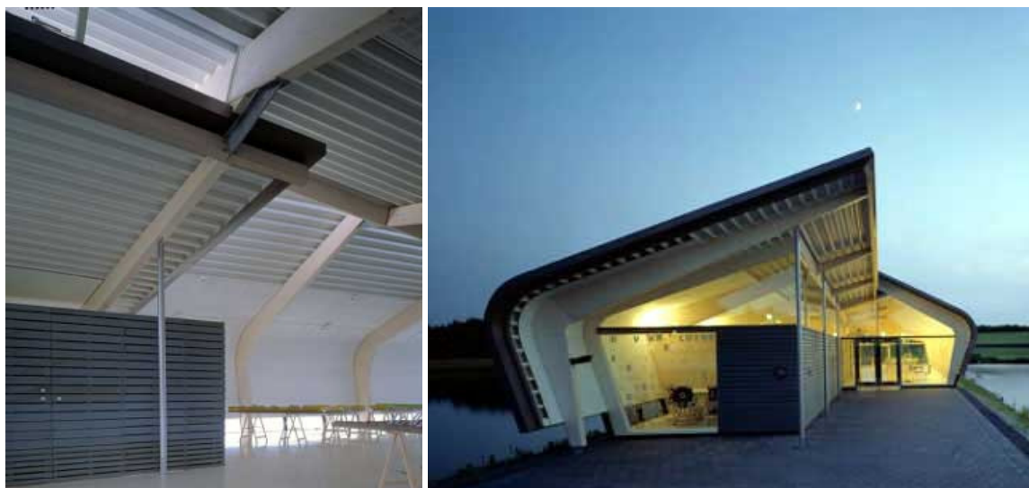
Rys. 5.70. Art Pavilion The Imagination, Zeewolde, Holandia. Architektura: René van Zuuk Architekten, [302].
