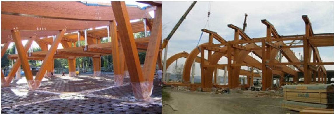
Rys. 5.74. Budynek Nuovo Gran Teatro Puccini w Torre del Lago we Włoszech. Architektura: Ufficio Tecnico di Progettazione CMSA - Ing. Giuliano Dalle Mura dello Studio Città Futura di Lucca, [324].
