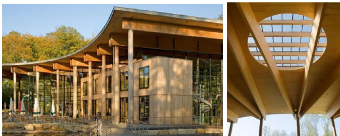
Rys. 5.29. Cloef-Atrium Besucher- und Tagungszentrum, Mettlach-Orscholz Saarland. Architektura: Wandel-Hoefler-Lorch Architekten GmbH. Konstrukcja: Geber + Müller, [227].
