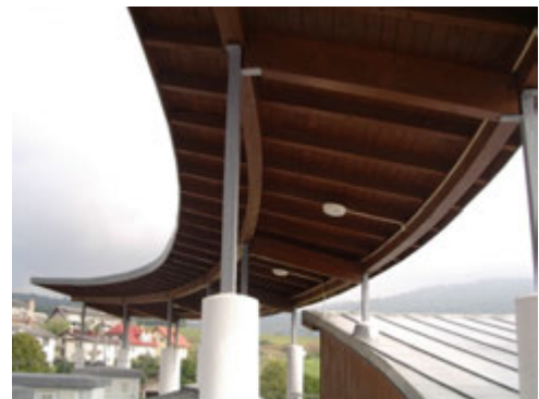
Rys. 5.10. Dach nad wejściem do Muzeum Mazurskiego Parku Narodowego w Krempnej, [335].
