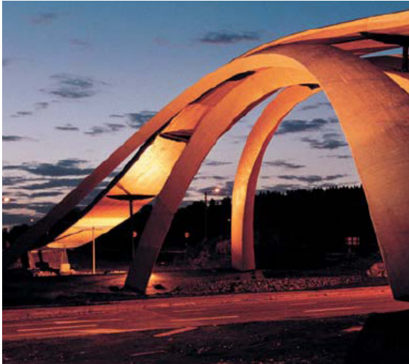
Rys. 5.8. Kształtowanie przekroju dźwigara nośnego giętego w dwóch płaszczyznach. Most Leonarda Da Vinci w Norwegii, [340].
