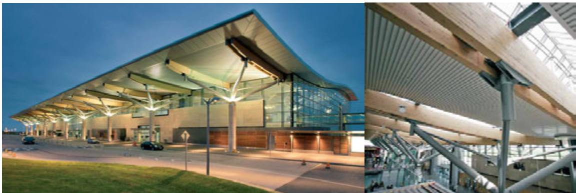
Rys. 5.77. Terminal lotniska w Cork, Irlandia . Rozpiętość dźwigarów: 45 m, [335].
